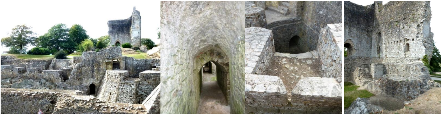
Tour polygonale sur les remparts; Coursive couverte desservant les casemates; Poste de défense; Intérieur du donjon
